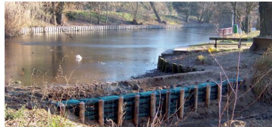
„Nährstoff-Falle“ mit FerroSorp® GW (2 - 4 mm) in Filtersäcken
